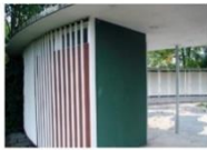
Garderobengebäude (Baujahr 1955) von Architekt Otto Dreyer.
